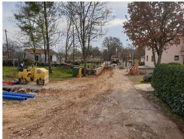
Za potrebe povećanja opskrbe vodom i protupožarne zaštite u Rapcu je izgrađen novi vodovodni ogranak (ulica Slobode do ceste uz rijeku). Ukupna vrijednost ulaganja iznosila je 402.011,62 kn.
